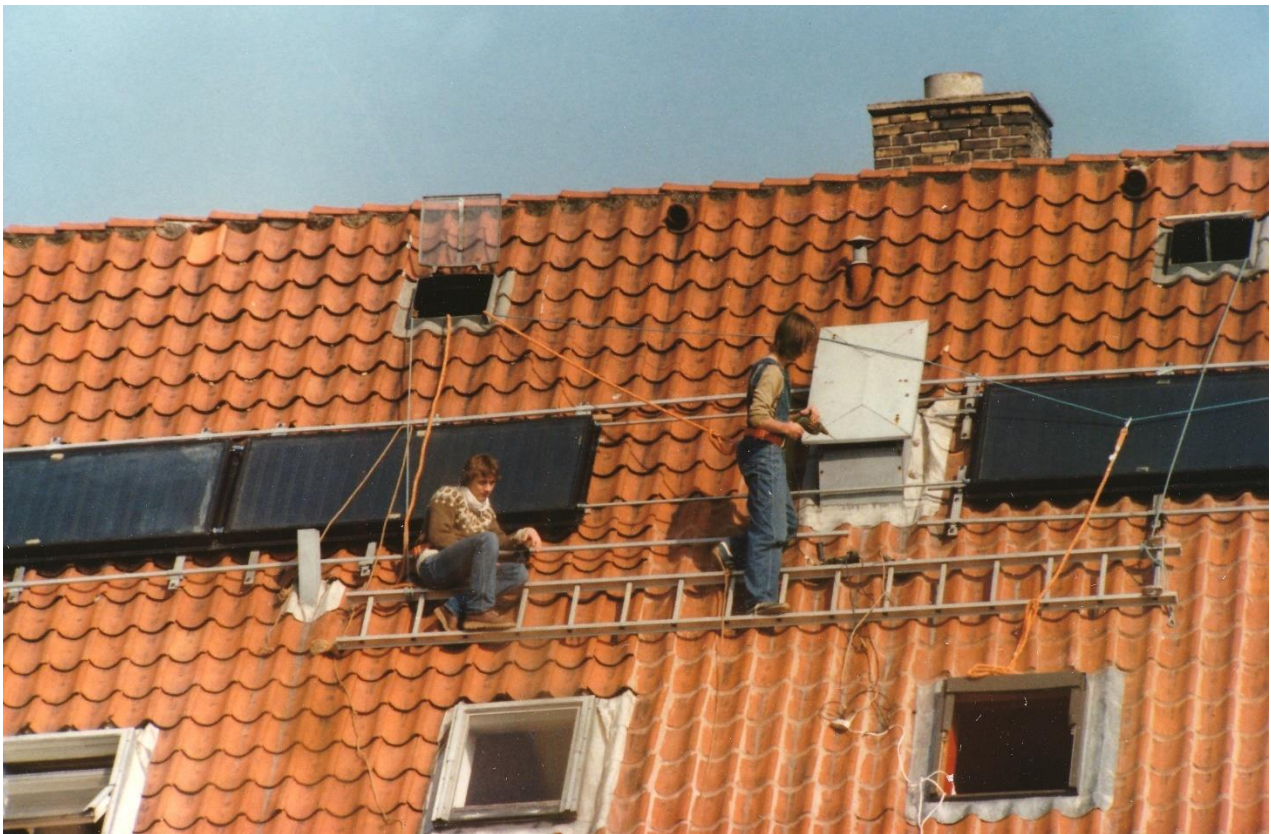
11. De første moduler af 85 m 2 solfangeranlæg monteres på teatersalens tag. Foto: Kaj Smedemark.
