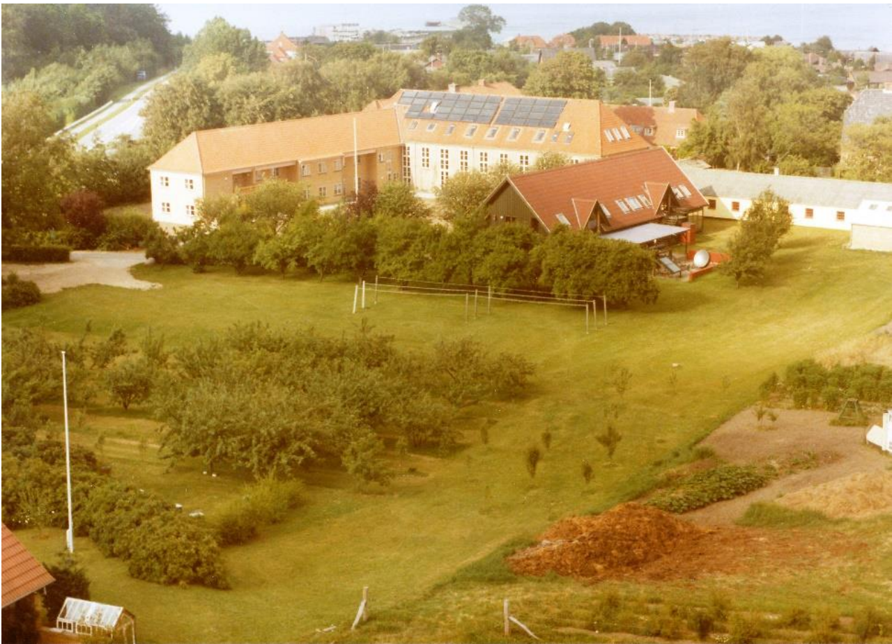
1. Danebod Højskole. 46 m 2 solfangere på taget. Billedet er taget fra toppen af det 18 meter høje tårn på Danebod Energiforsynings 48 kW-mølle i 1983. Foto: Kaj Smedemark.
